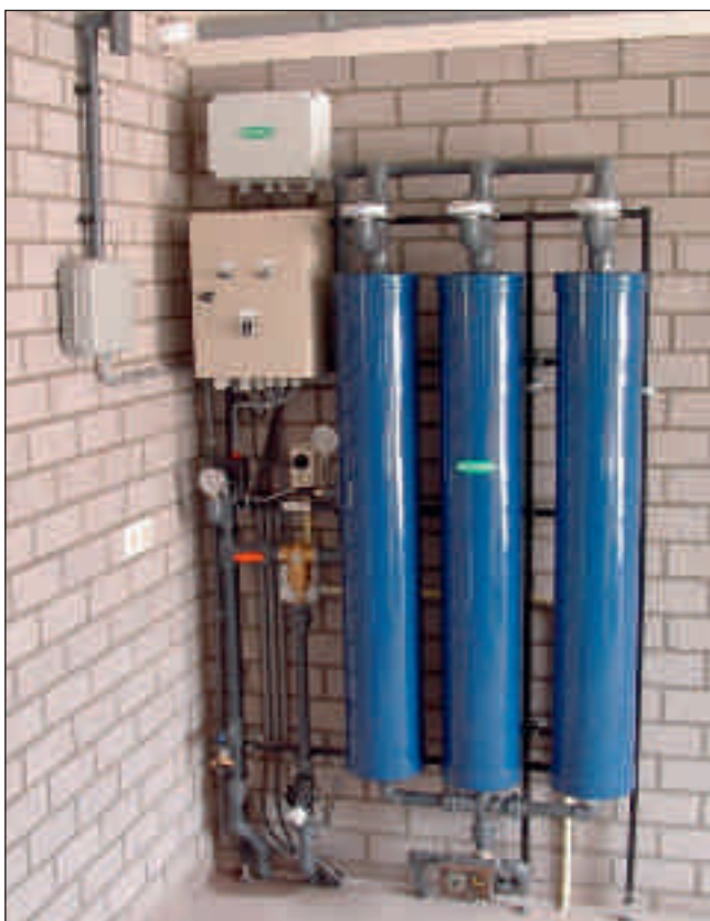
Compacte opstelling van de apparatuur
